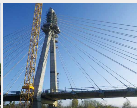
Pomical, Viadotto strallato / Cable-stayed bridge SP456 del Turchino (Cismondi)
